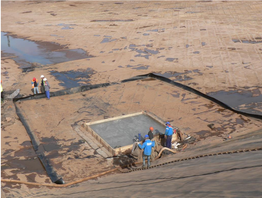
Figure 12. Reprise de l'étanchéité sous le diffuseur
