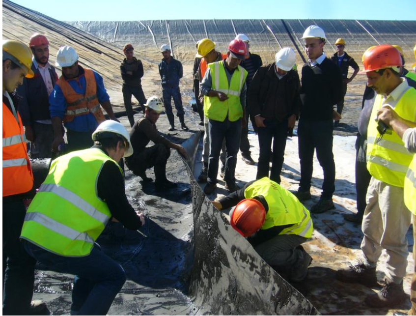
Figure 10. Opérations de constat des désordres
