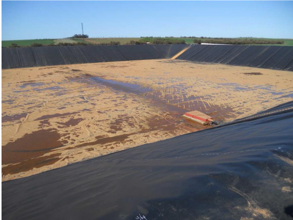
Figure 2. Vue générale du bassin étanché et du diffuseur
