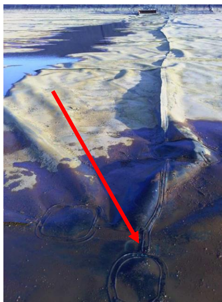
Figure 7. Localisation d'une fuite sur point triple
