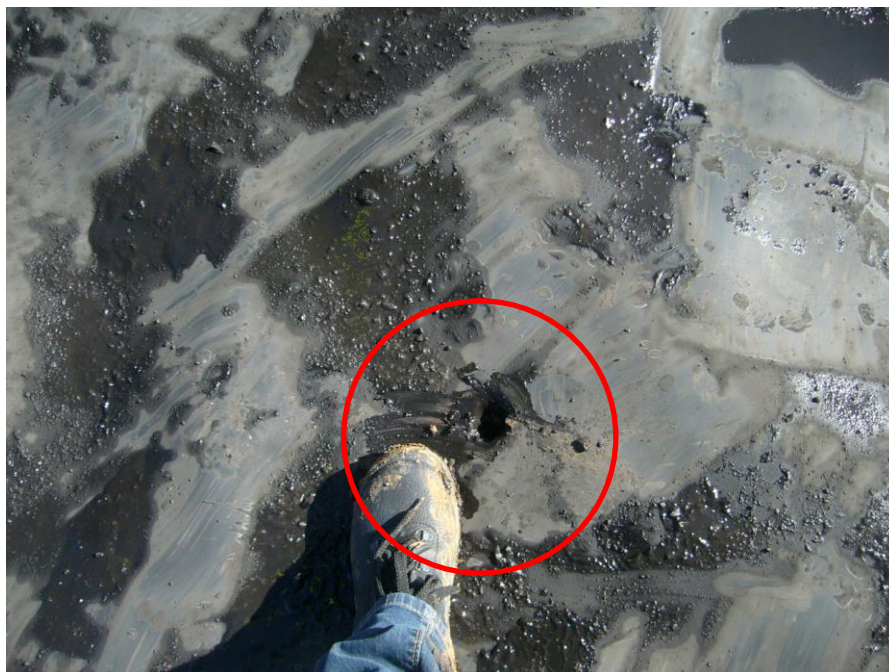
Figure 11. Défaut lié à un poinçonnement de la géomembrane constaté après démantèlement de la dalle béton
